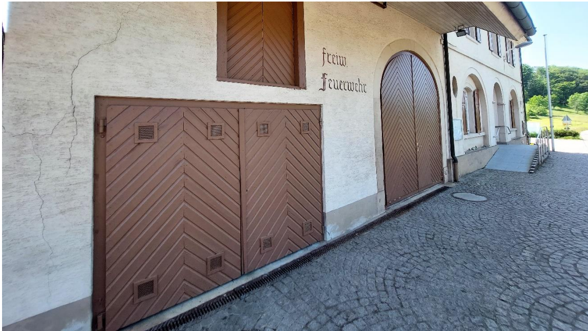
Abbildung 4: Tore der Feuerwehrgarage erneuert
